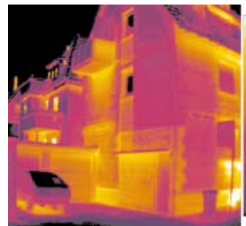
Hier eine Thermografie-Aufnahme eines Reihenhauses (mit Temperaturskala)
